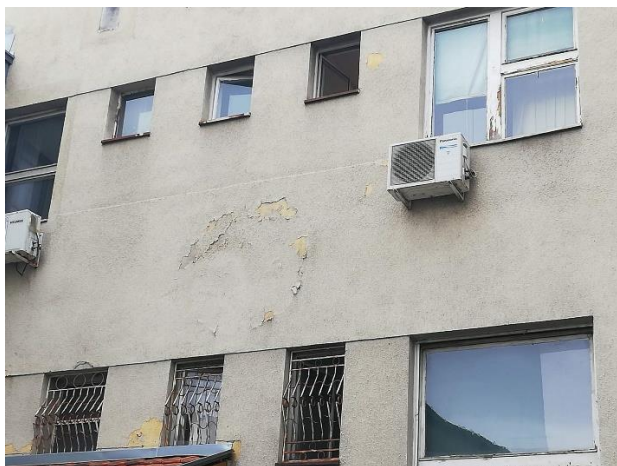
Сл. 3 – Оштећење задњег дела фасаде
