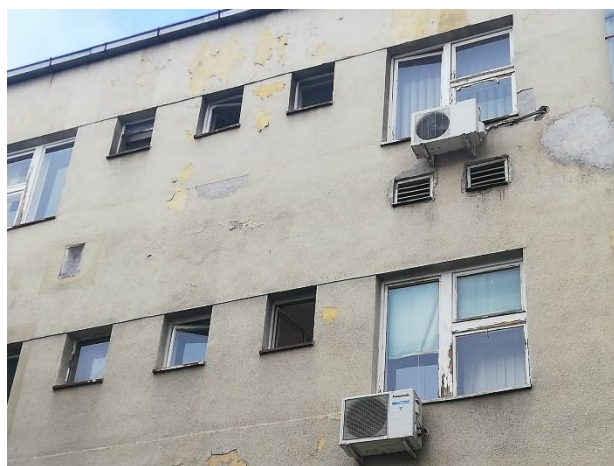
Сл. 3 – Оштећење задњег дела фасаде
